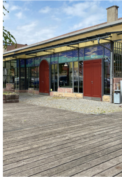
Außenbereich &amp; Terrasse
